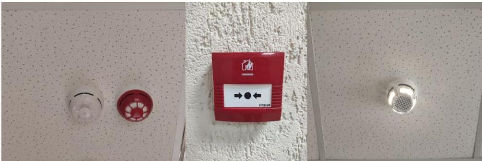
**Рис. 2.** Тепловой извещатель «Аврора-Т-ПРО» и звуковая сирена «Сирена-ПРО»;
