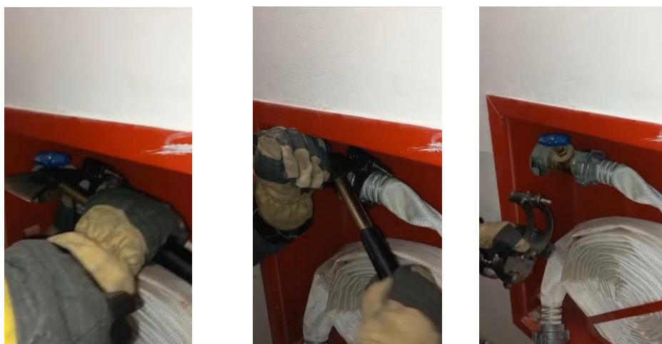
Рис. 4. Работа топором поясным пожарным по размыканию запорного устройства «МИВ-1»
