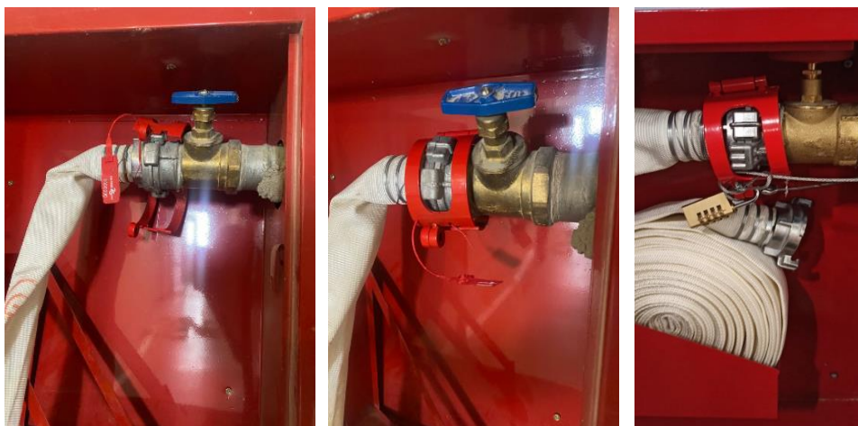
Рис. 3. Установка запорного устройства «МИВ-1 (исп.01)» на полугайке пожарного крана с рукавом
