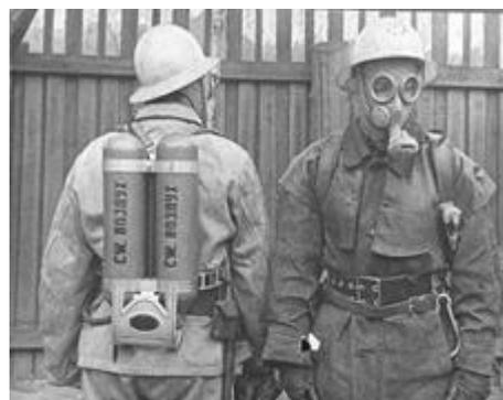
Рис. 6. Прототип первого ДАСВ
