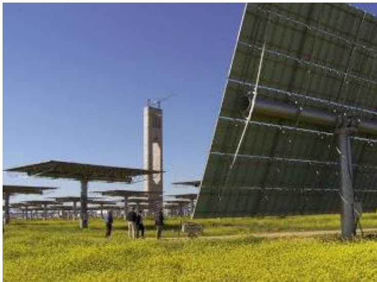
Рис. 1. Солнечная электростанция башенного типа
