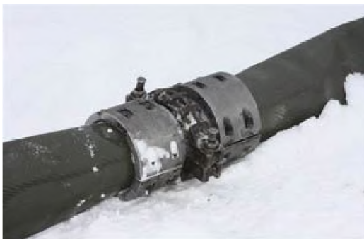
Рис. 4. Процесс соединения полугаек
