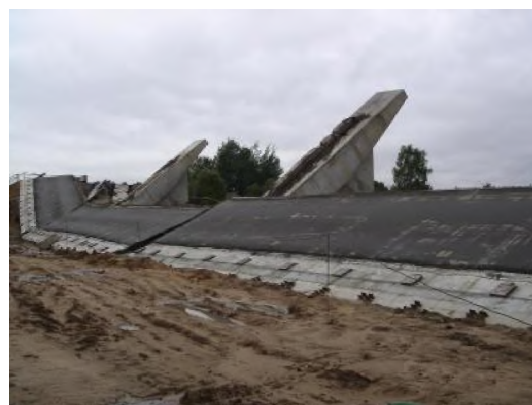
Рис. 2. Фотография с места разрушения моста
