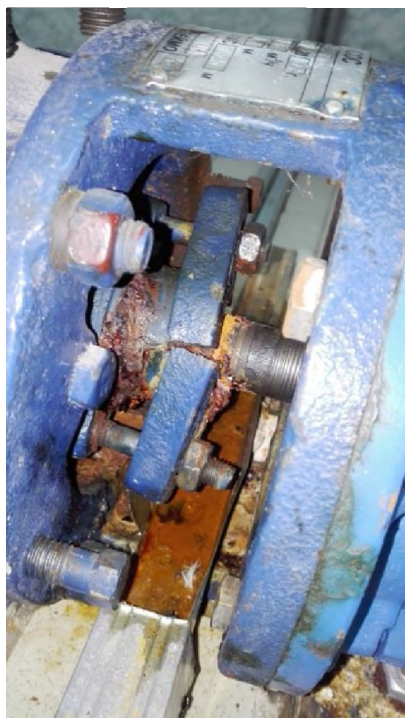
Рис. 1. Нарушение устройства уплотнения в центробежном консольно-моноблочном насосе
