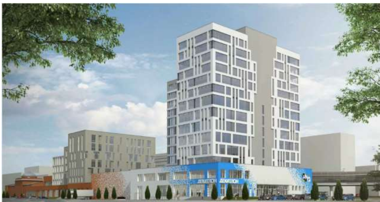
Рисунок П5.1 – Внешний вид торгово-офисного здания, расположенного по адресу: 115280, г. Москва, ул. Автозаводская, д. 23А, корпус. 2
